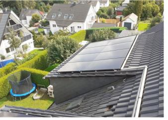
Auch bei unseren Solar-Hybridkollektoren als Wärmequelle ist keine Außeneinheit erforderlich aber sinnvoll, denn im Sommer kann hierdurch überschüssige Wärme in den Kollektoren mit nur wenig Stromeinsatz heruntergekühlt und dadurch mehr Strom produziert werden. Photovoltaikkollektoren produzieren ja bekanntlich mehr Strom umso kühler sie sind.
