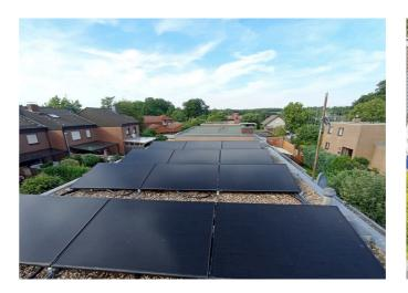
Genauso wie bei unserem Heizzaun, zirkuliert auch in unseren patentierten sunsation (www.sunsation.com) Solar-Hybridkollektoren die Sole zwischen der Inneneinheit und den Solar-Hybridkollektoren, also ebenfalls ein völlig geräuschloser großer Wärmetauscher, der permanent die Umgebungstemperatur aufnimmt und der Wärmepumpe zuführt, aber durch die Photovoltaikzellen auf der Vorderseite auch gleichzeitig Strom produzieren.
